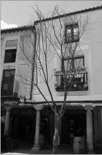
Fachada reformada de la antigua "Posada de Cervantes"
