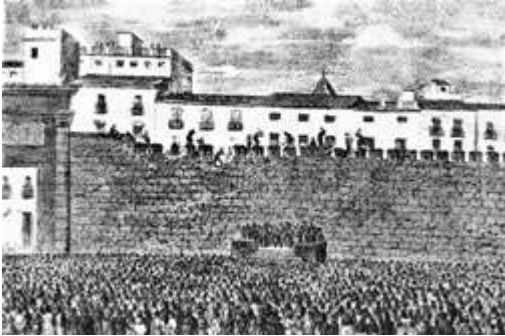
20 febrero 1865. Junto a la Puerta del Real se inició el derribo de las murallas de Valencia, siendo gobernador de la ciudad D. Cirilo Amorós Pastor.
