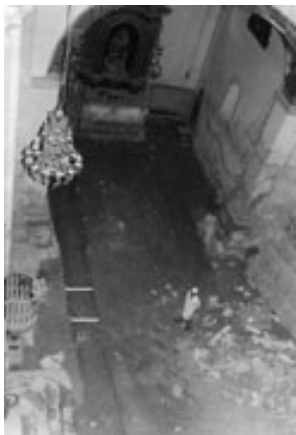
Restos de muro aparecido en el crucero durante la cimentación de las obras de 1990-1992.
