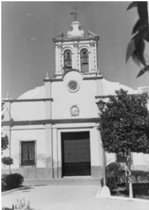
Fachada iglesia de La Luisiana.
