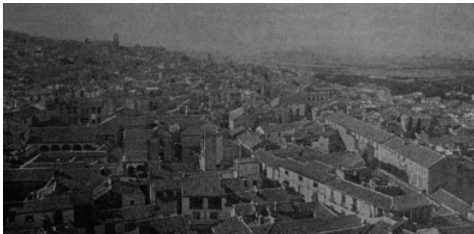
Jaén. Vista parcial.
