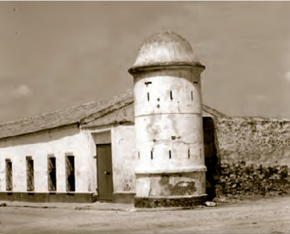
Antiguo Cuartel de la Guardia Civil. Calle San Pascual esquina, calle Zoa / FOTO: Francisco Sala.
