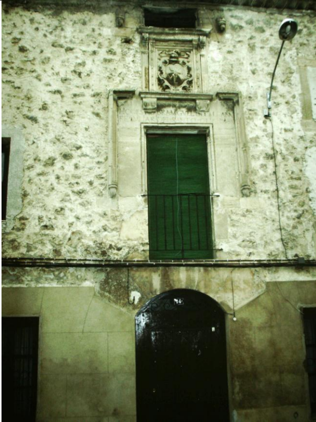
Fachada de una casa de la calle Larga.
