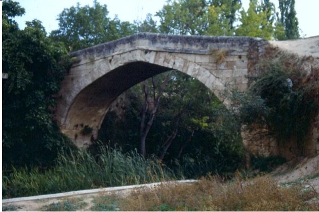
Puente Liende en el río Escabas.
