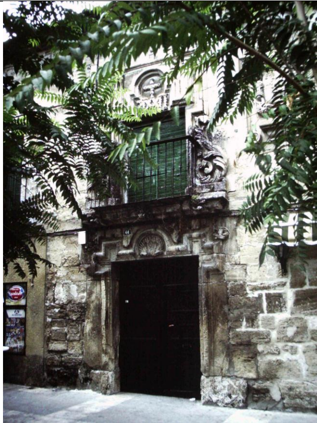
Fachada con escudo nobiliario.
