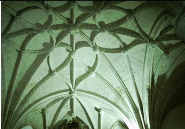
Detalle del techo.
