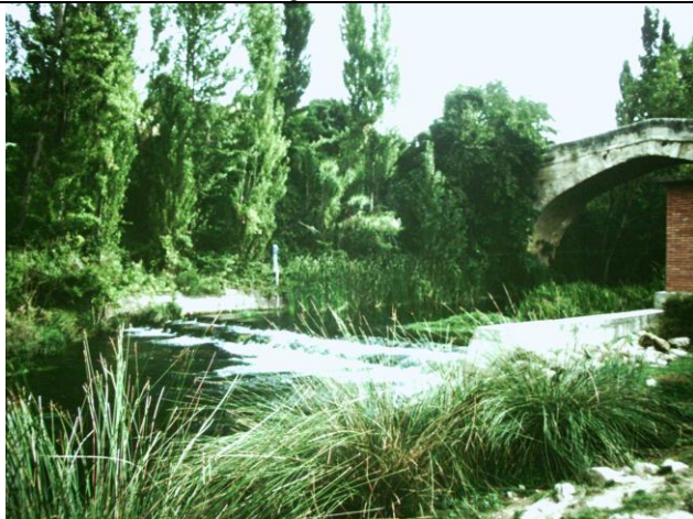
Puente Liende en el río Escabas.
