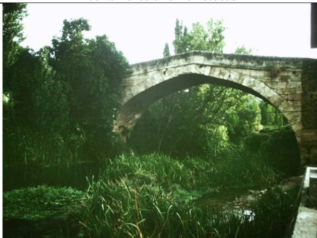
Puente Liende en el río Escabas.
