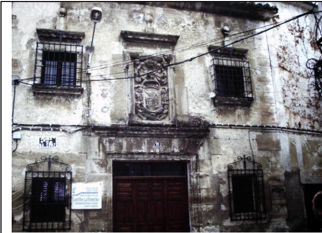
Fachada con escudo nobiliario.
