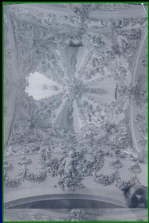
Cúpula del vestíbulo de acceso al Sagrario.
