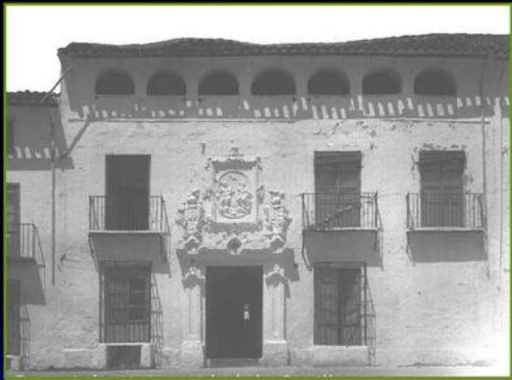
Casa de Andrés Portales. Calle San Francisco, 10.
