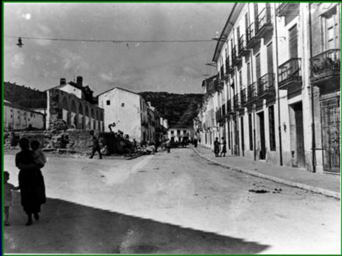
Derribo del Pósito en los años republicanos.
