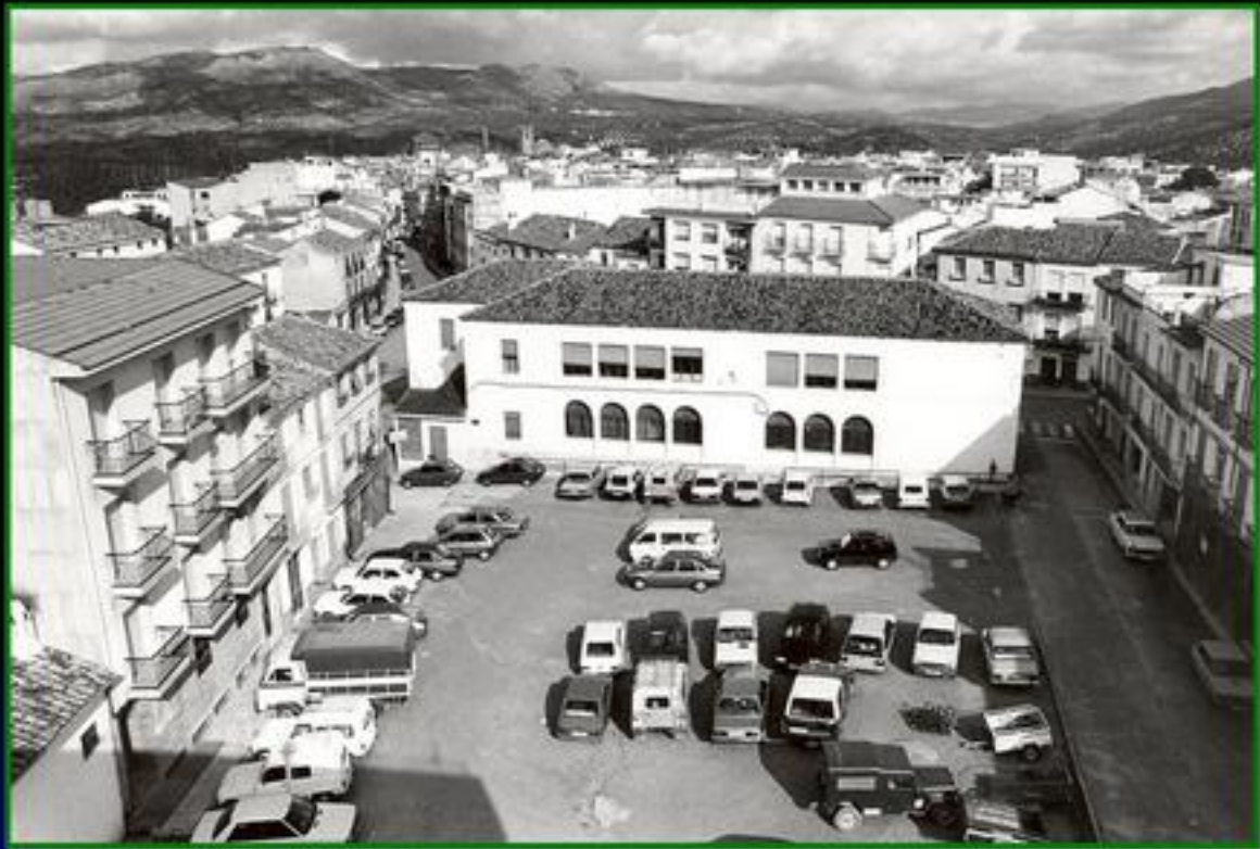
Panorámica de la parte posterior del colegio.
