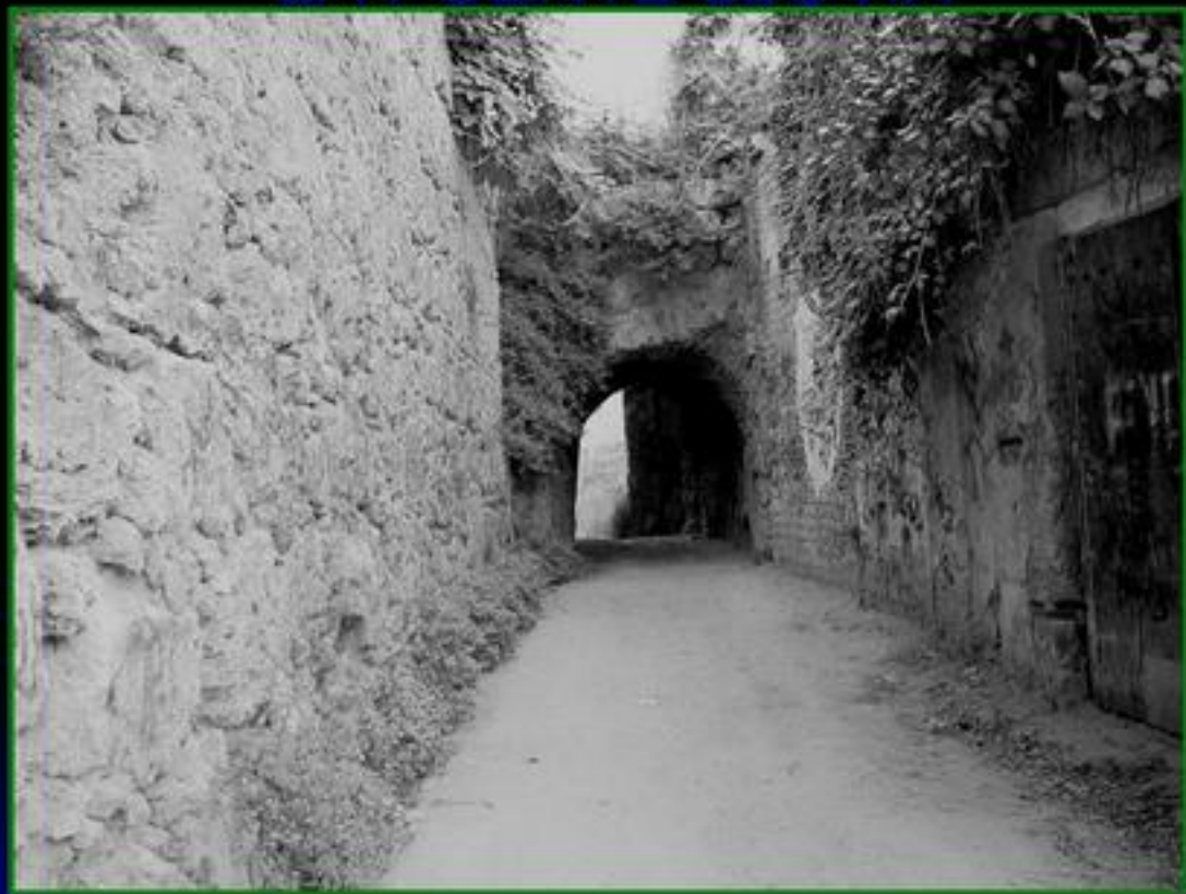
Muralla medieval y puerta.
