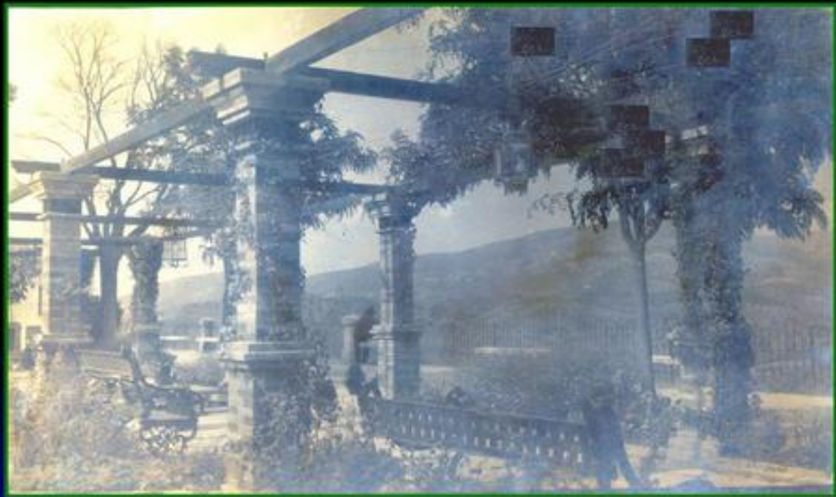
Detalle de las pérgolas construidas en 1927 con diseño de Francisco Ruiz Santaella.
