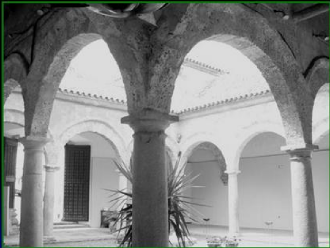
Detalle de las arcadas.
