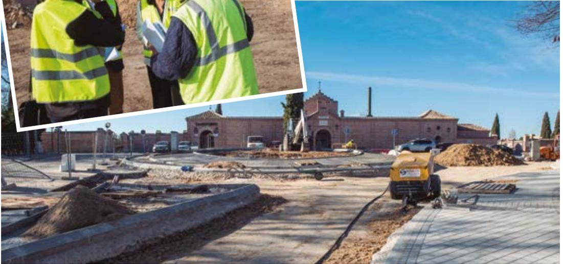
Las obras de la rotonda del cementerio evolucionan a buen ritmo y actualmente se está ejecutando la fase de hormigonado y la conexión de alumbrado.
