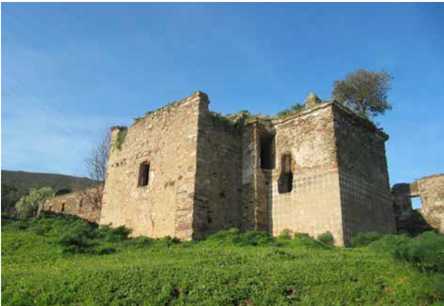
Detalle del ábside de la iglesia conventual
