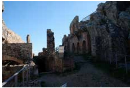
Acceso al sótano
