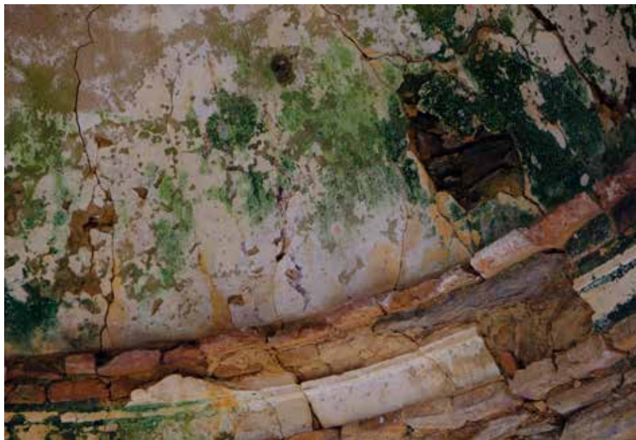
Detalle de la bóveda
