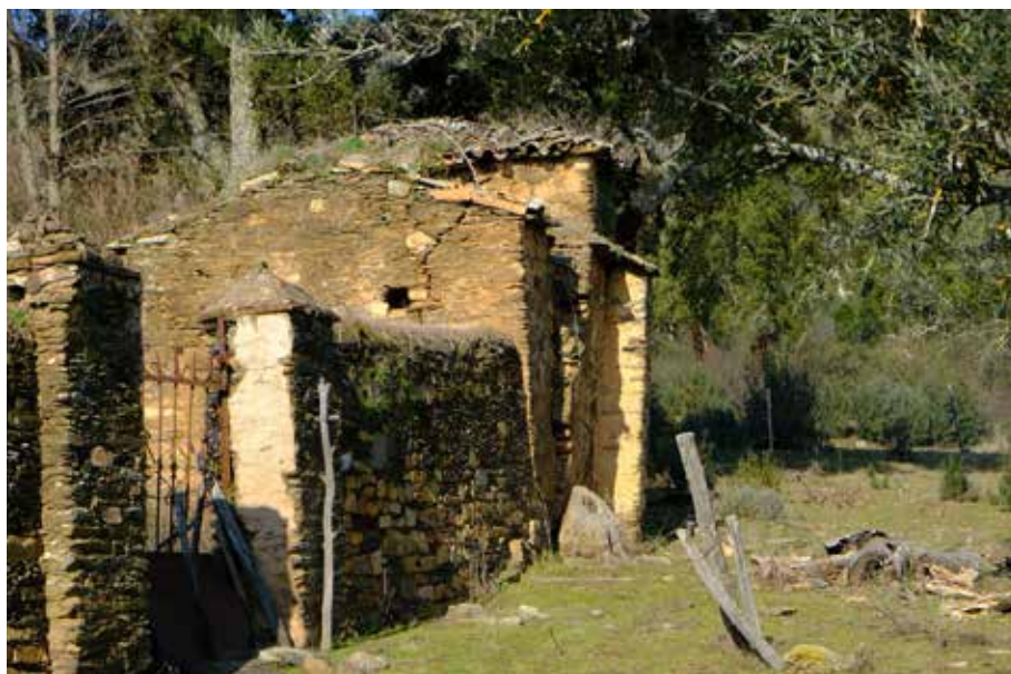
Lateral de la ermita, contrafuerte
