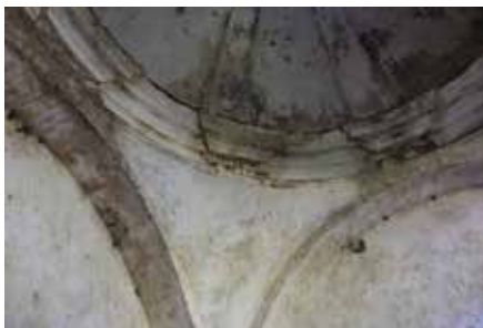
Detalle de la bóveda de la capilla mayor
