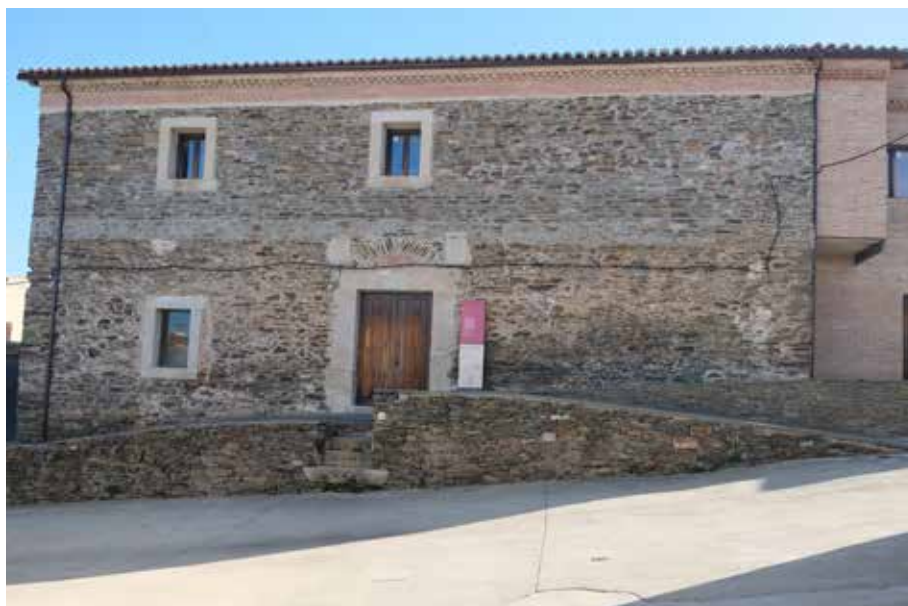
Fachada del hospital
