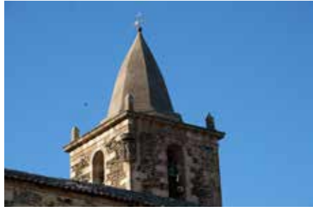
Remate de la torre, pináculos de ladrillos
