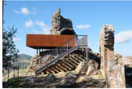
Detalle de la torre
