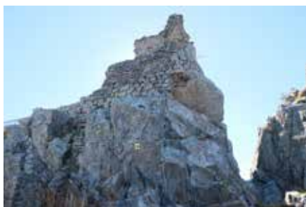
Restos de la torre
