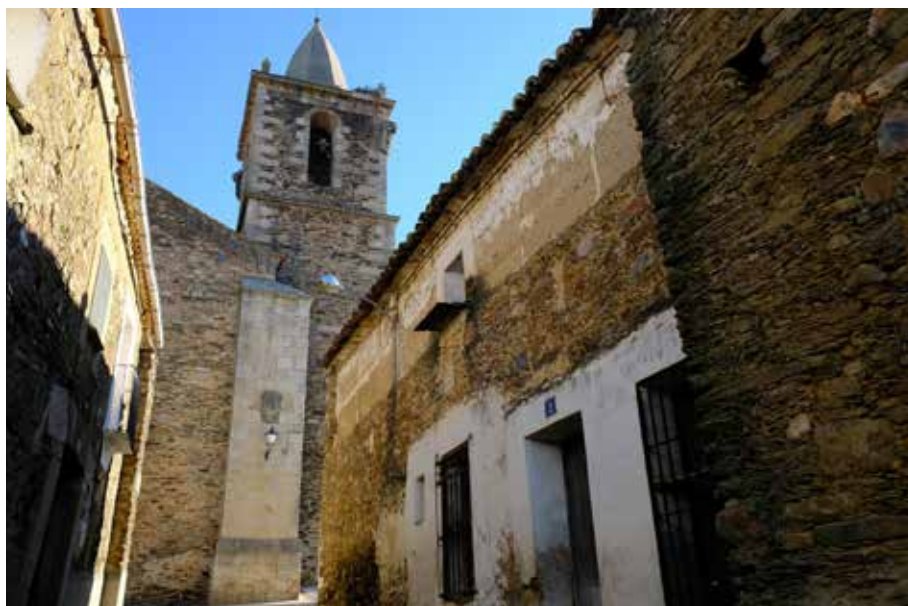
Calle de la Iglesia
