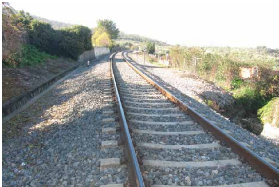
Vía férrea a su paso por Mirabel
