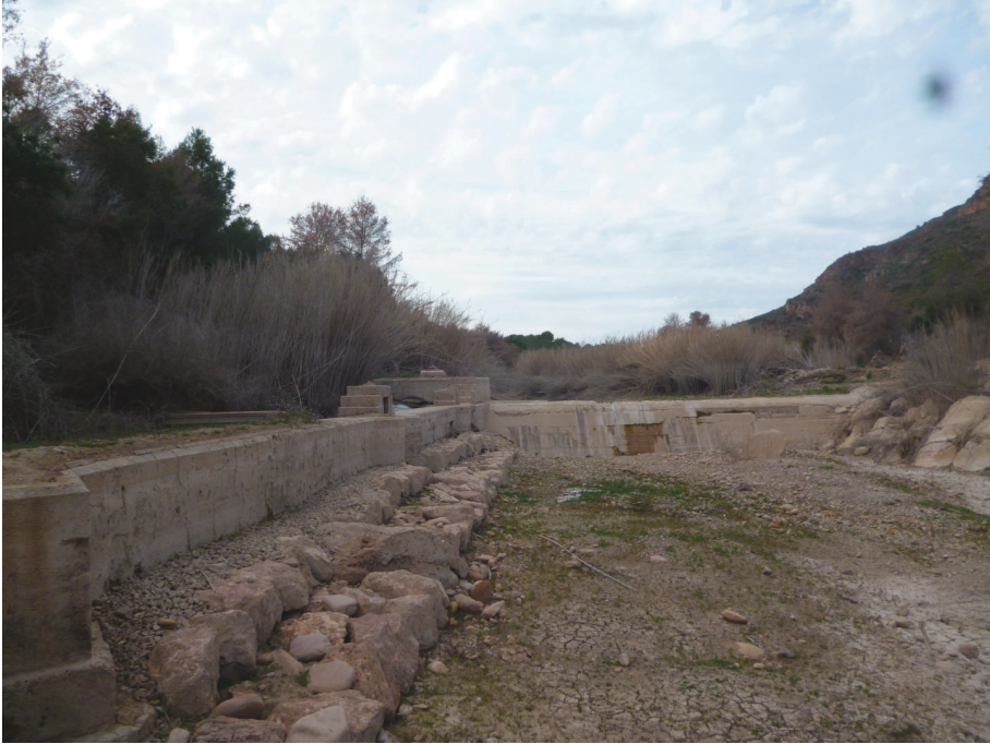
Azud de Algar con huellas de sillería romana
