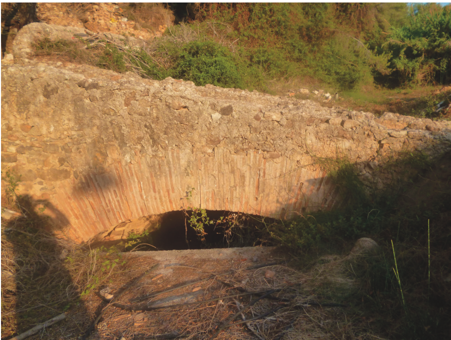
Posible puente romano sobre la acequia mayor de Sagunt
