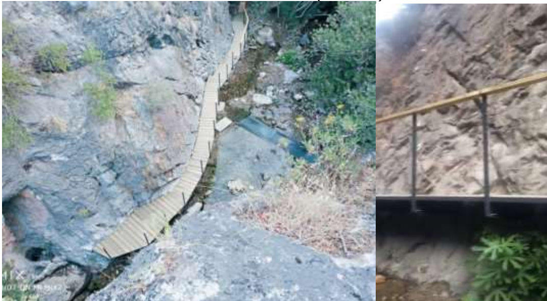
Vista y detalle de la nueva pasarela sobre el río Cuadros (Bedmar) entre el Adelfar y los Nacimientos del Sistillo.
